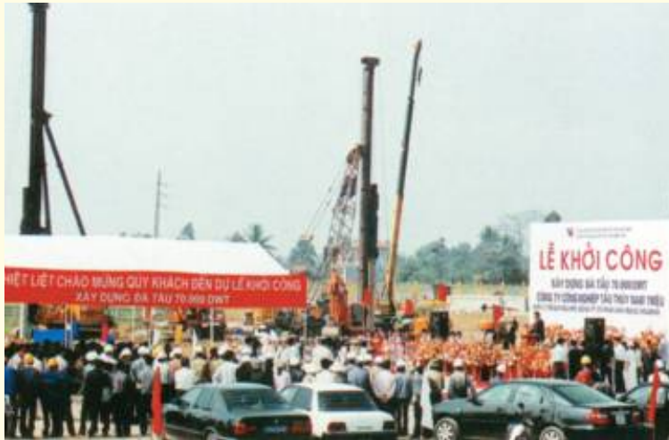
Lễ khởi công xây dựng đà tàu 70.000 tấn
